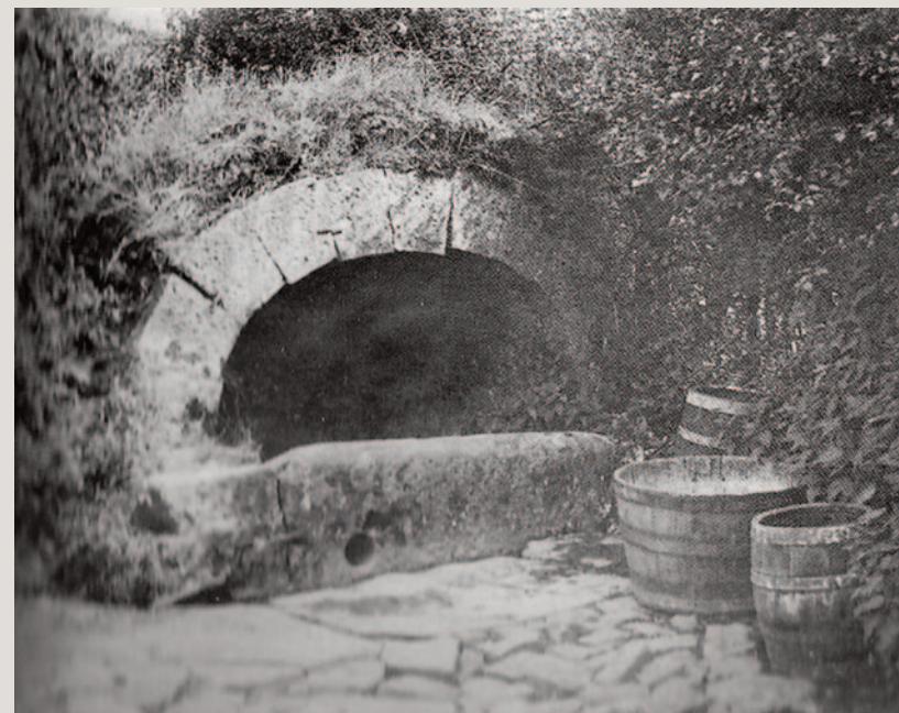
Figure 44. Vers 1942, une des trois 'goffes' construites vers 1853, démolies vers 1963, captages de sources ; ici celle du 4, rue du Staplisse, une autre à la Laiterie, rue d'Awenne.
