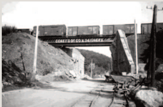
Figure 25. La reconstruction de l'un des ponts de chemin de fer de Grupont.
