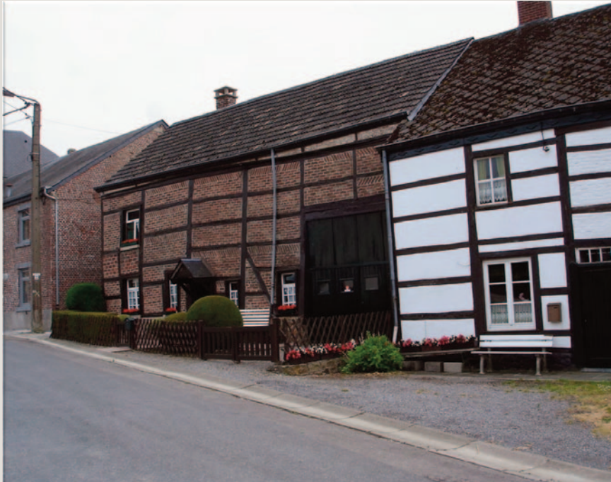
Figure 33. Les évolutions. L'école des filles convertie en salle des fêtes ; la maison 'de Cuyper' réhabilitée par les Verzin de Gand, devenus 'du pays', avec écurie convertie en complément de logis ; la maison Mathot au colombage revalorisé, bientôt gîte touristique.
