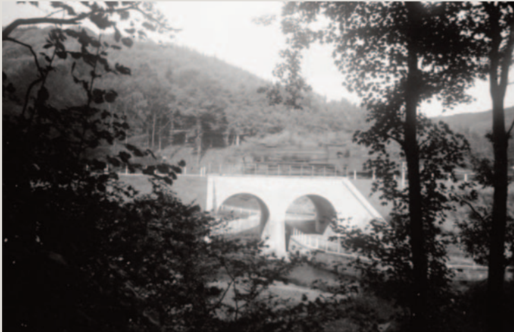
Figure 21. Le pont du Block, vu du chemin remontant de l'ancien passage à niveau vers Marie Gobaye ; à droite, le passage venant du village et du Parfond'ry vers les Affrus et le quai en direction Grupont ; à la reconstruction, a été aménagé, dans la pile centrale, un logement pour une charge explosive, en prévision de la prochaine guerre, des prochaines... Source : Jean-Claude Zélis
