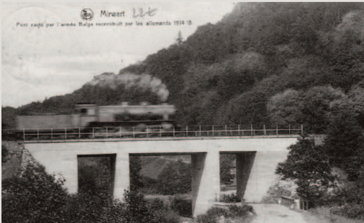
Figure 23. Le pont du chemin de fer sur la Lomme, au confluent du Marsoul et sur la route de Smuid. L'architecte de la reconstruction en 14-18 n'aura pas prévu, pour le gabarit du passage, l'invasion des Ardennes par les SUV...
