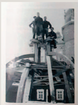
Figure 50. Pour réparer la coupole de la tour incendiée, les charpentiers ont d'abord effectué un montage au sol. Par la suite, ont démonté la structure en bois pour la replacer au-dessus de la tour.
